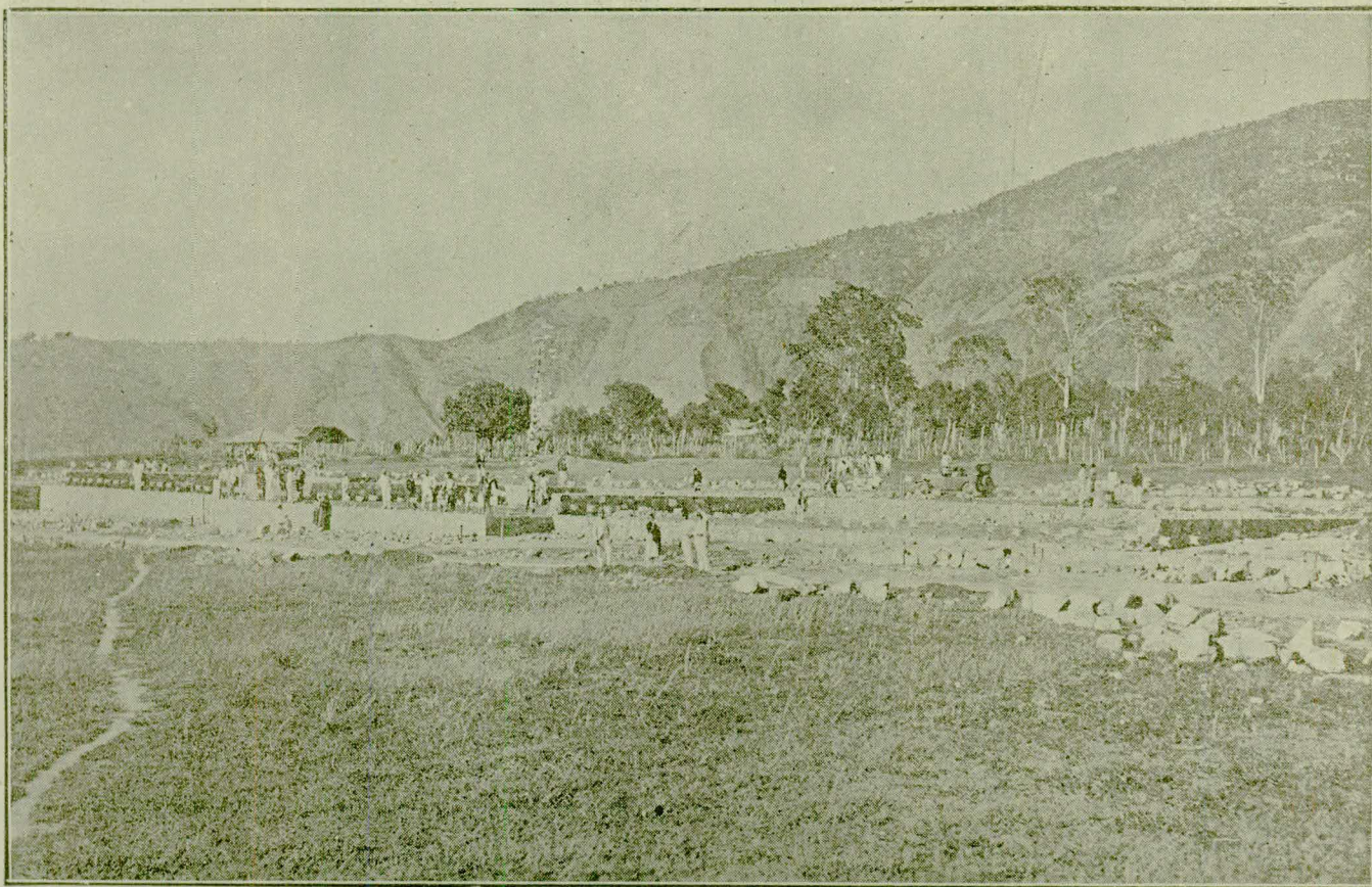
TRABAJOS DE CONSTRUCCION DEL CUARTEL DE BUCARAMANGA.—BASAMENTO DEL PRIMER PABELLON (DORMITORIO) VISTO DE FRENTE
