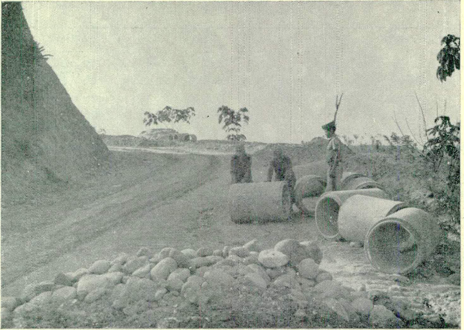
CARRETERA EL CASTILLO-MESA DE YAMANES (META) CONSTRUIDA POR EL BATALLON DE INGENIEROS "BARAYA".
