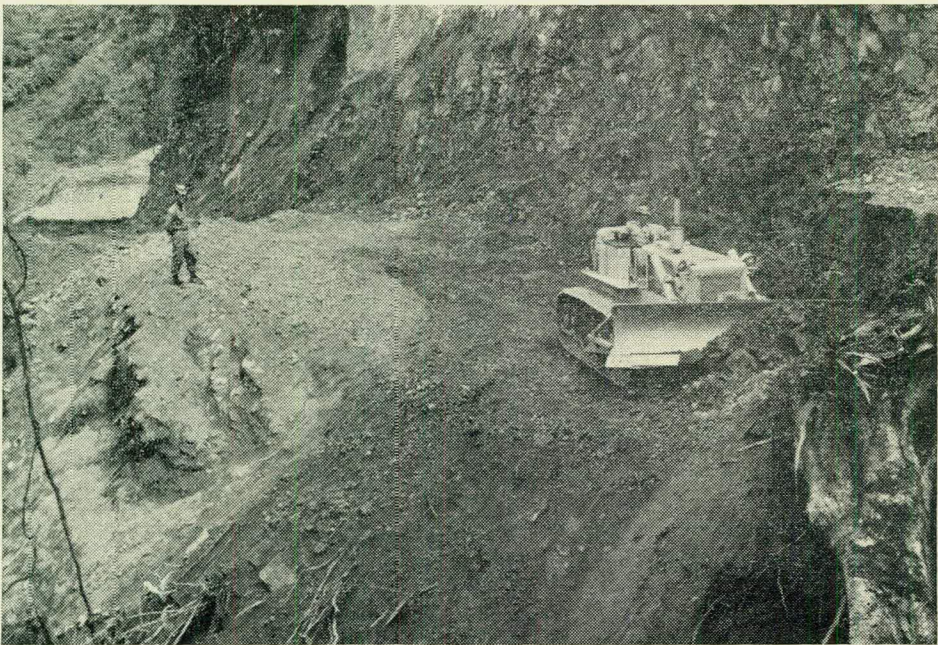
ASPECTO DE LA CONSTRUCCION DE LA CARRETERA TACUEYO-TOEZ POR UNIDADES DE INGENIEROS MILITARES.
