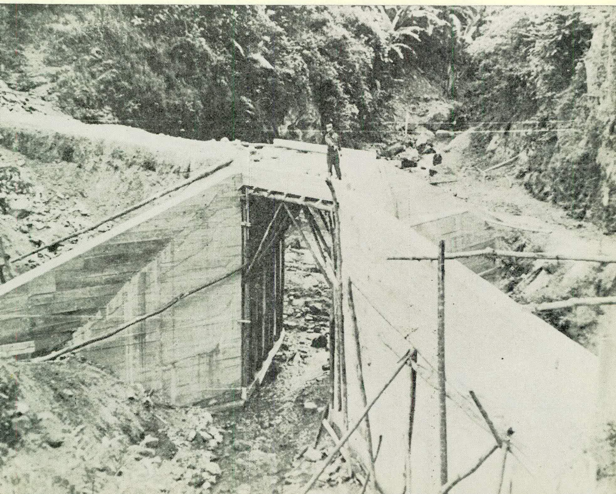
ASPECTOS DE LA CONSTRUCCION DE UN PUENTE SOBRE LA QUEBRADA CACHIMBO, VIA PACARNI-IQUIRA
