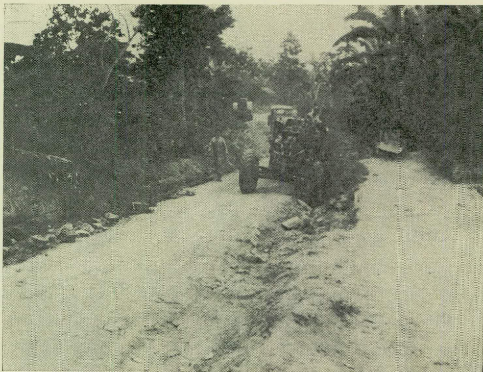
TRABAJOS DE NIVELACION EN LA RECONSTRUCCION DE LA CARRETERA "CARCASIA - LA CRISTALINA - ARMENIA".
