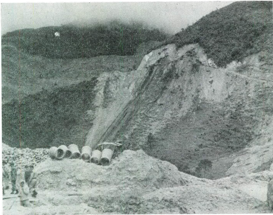
TRABAJOS DE EXPLANACION EN LA CARRETERA PALMIRA-ATACO
