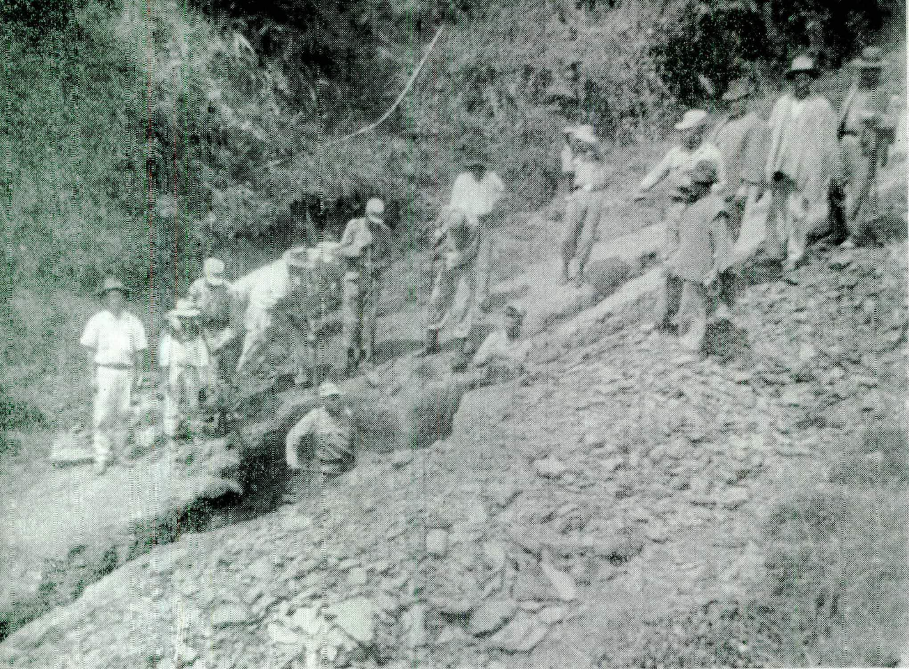
APERTURA DE ZANJAS PARA LA CONSTRUCCION DEL ALCANTARILLADO EN VELEZ (S. S.).
