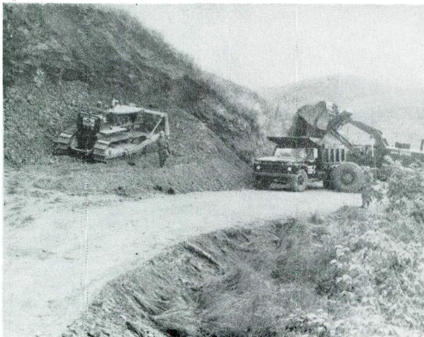
MANTENIMIENTO CARRETERA LA BUITRERA-CHONTADURO-LA ZAPATA
