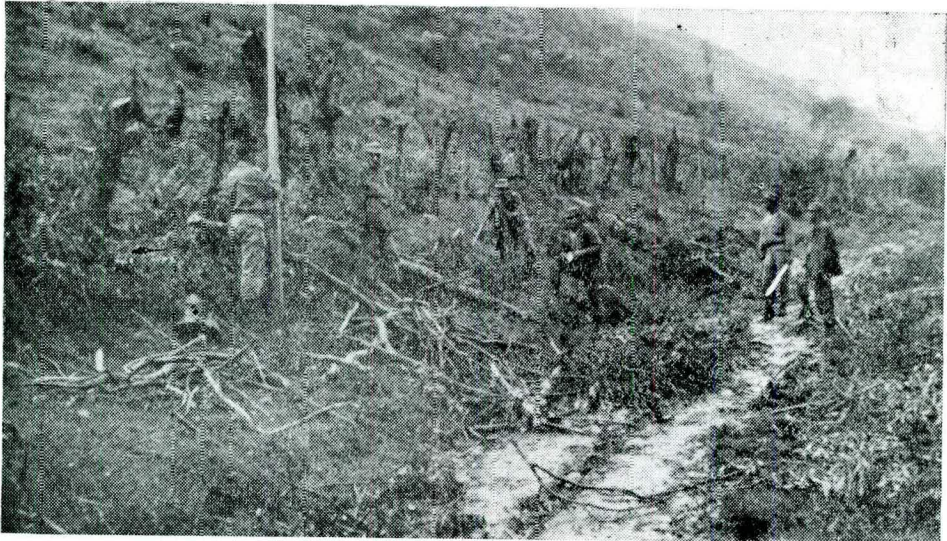
EQUIPO DE TOPOGRAFIA EN TRABAJOS DE TRAZADO DE LA CARRETERA TACUEYO TOEZ, DEPARTAMENTO DEL CAUCA
