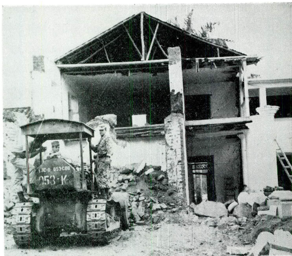
DEMOLICION DEL HOSPITAL DE GARZON, AVERIADO POR EL TERREMOTO
