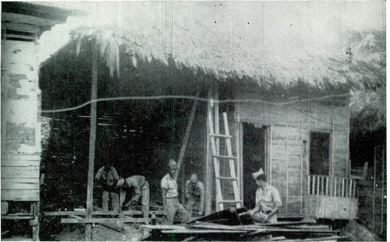
CONSTRUCCION DE VIVIENDAS CAMPESINAS
