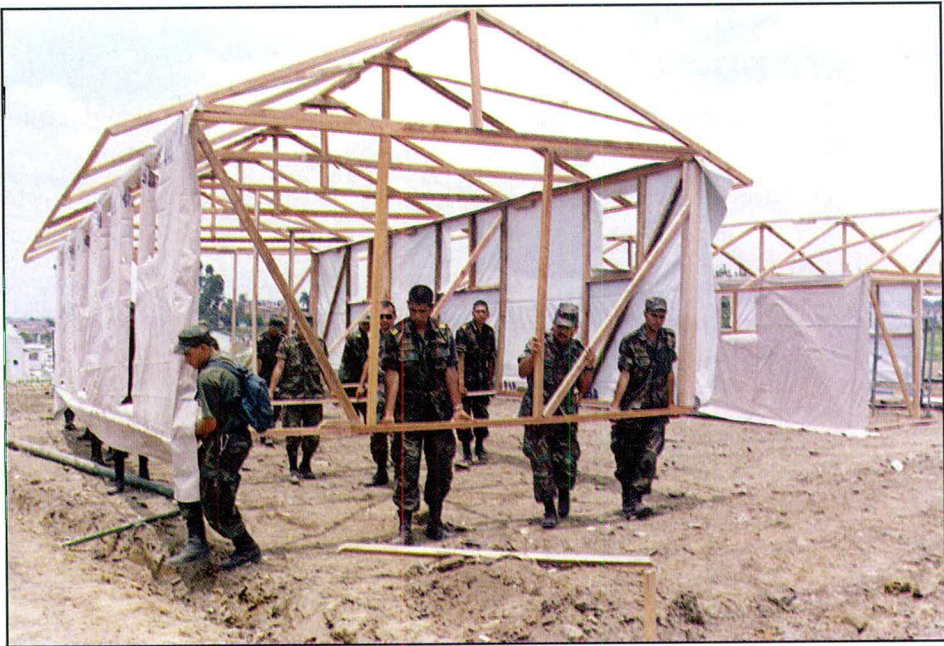
Construcción de viviendas en zonas de desastres
