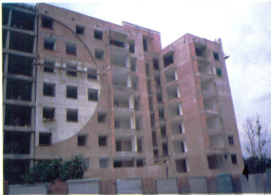
Cincuenta y seis apartamentos para oficiales en Santafé de Bogotá (edificio Tequendama) en construcción
