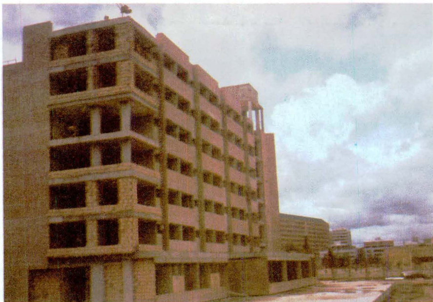
Panorámica del edificio en construcción para oficiales alumnos que adelantan cursos en la ciudad de Santafé de Bogotá.
