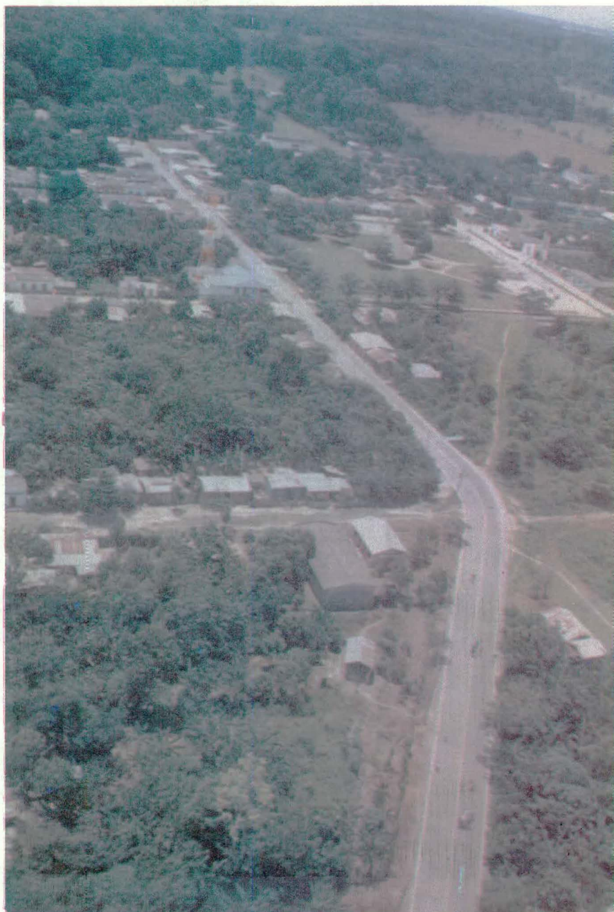
Pavimentación carretera Bojabá - Saravena - Arauquita (Arauca). BATIN No. 5 "Caldas".
