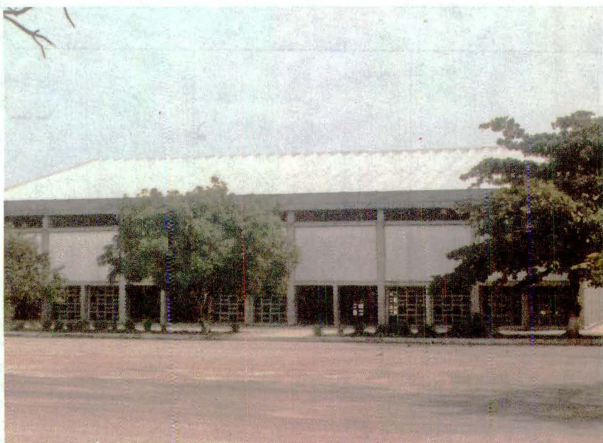
Proyecto de infraestructura. Cambio de cubierta coliseo Escuela Naval. Cartagena.
