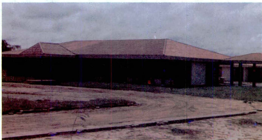
Instalaciones Comando Operativo No. 2 Arauca (Arauca), construidas. BATIN No. 5 "Caldas".
