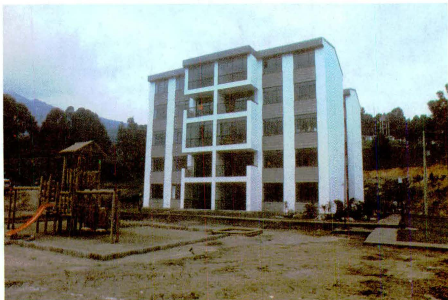
Aspectos generales del edificio Yariguies para suboficiales, construido en el Batallón de Policía Militar No. 4 de Medellín.
