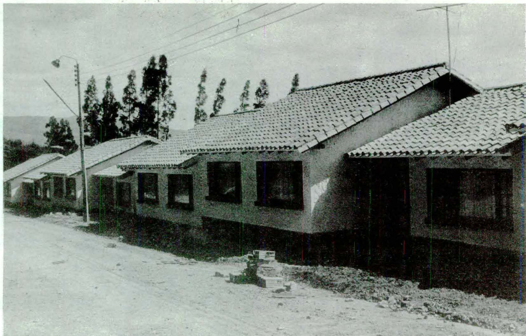
Vista panorámica de las viviendas fiscales para suboficiales construidas en la Guarnición de Bonza
