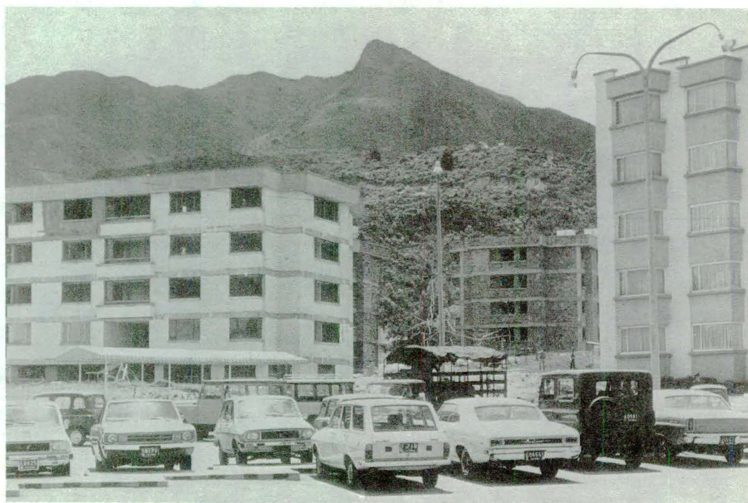
Vista parcial de 3 bloques de apartamentos en ejecución, con destino a oficiales en el Cantón Norte de Bogotá
