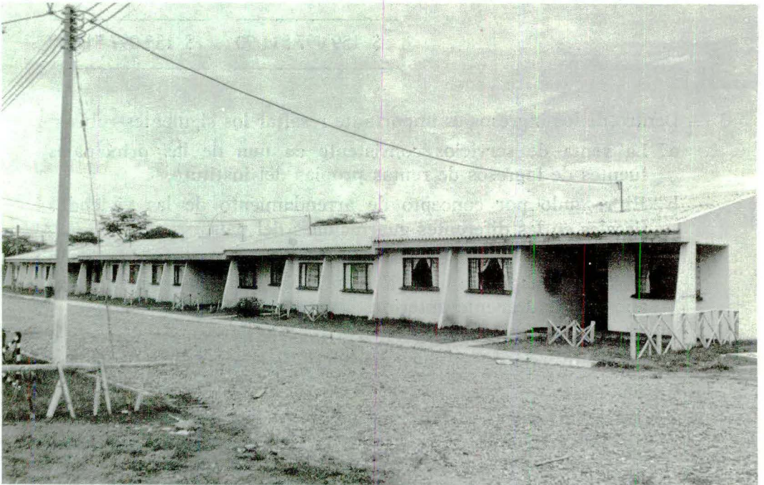
Fachada principal de las casas para suboficiales construidas en predios del Batallón Pichincha
