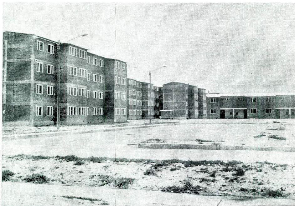
Conjunto residencial "Francisco José de Caldas" para Suboficiales en Bogotá.
