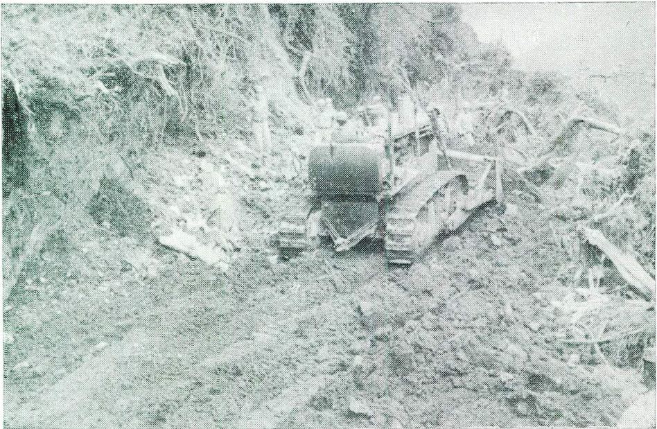
La construcción de la vía TACUEYO-TOEZ se efectúa a una altura de 3.600 metros sobre el nivel del mar por lo cual la topografía es muy abrupta y las condiciones climáticas reinantes dificultan enormemente el rendimiento de las máquinas.
