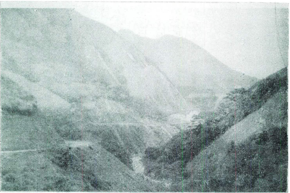
Panorámica que muestra un sector de la carretera CHIMA-CONTRATACION en el Departamento de Santander. La obra se terminó en el presente año, logrando así la materialización de una vieja aspiración de los habitantes de la región. La vía fue construida por el Batallón BARAYA y continuará hasta SANTA ELENA.
