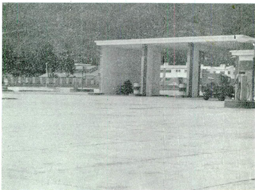
Patio de cemento construido en la Bomba de Gasolina de la Escuela de Armas Blindadas.
