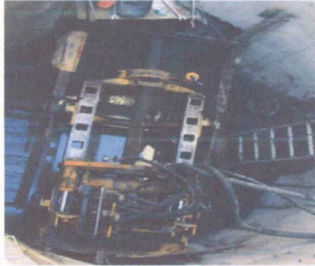
FIGURA NO. 16 MICROTUNELAJE 12
