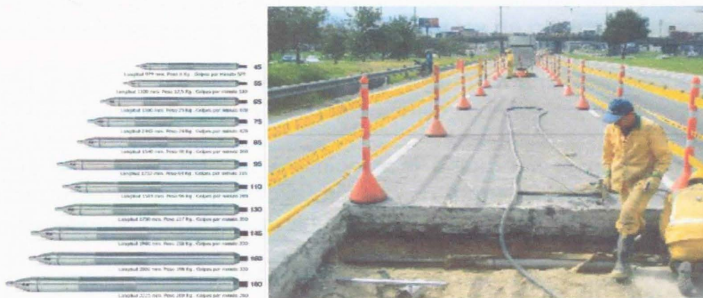
FIGURA NO. 12 PERFORACIÓN SIN ZANJA 7
