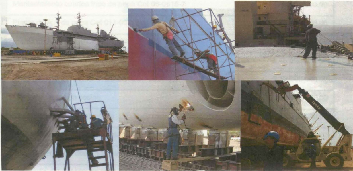
Figura 19 Trabajos de reparación ARC Cartagena de Indias 2006-2007
