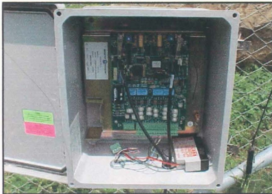
Unidad central de control sistema de detección de intrusión (Cable microfónico) Instalaciones Pozos de perforación. Complejo petrolero Casanare. BP EXPLORATION..
