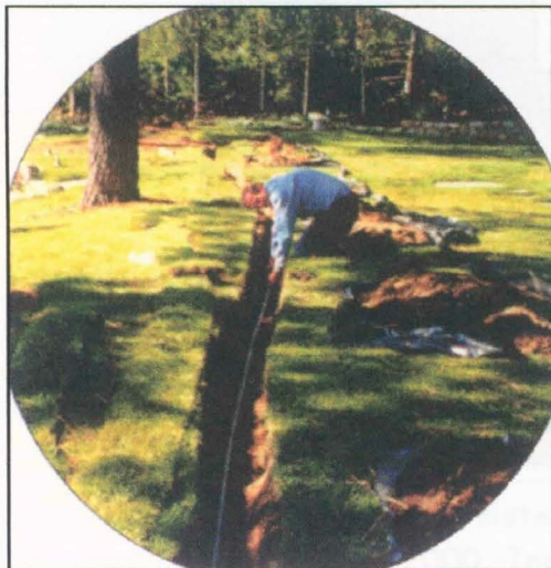
Instalación del Sensor Coaxial Inteligente PERIMITRAX
