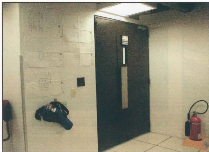
Sistema de control de acceso, mediante lector magnético. Oficinas OCENSA. Bogotá D.C.
