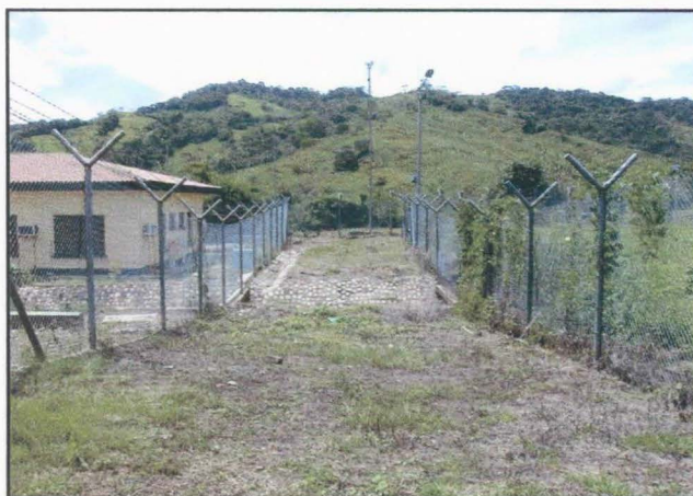
Doble malla de encerramiento de instalaciones. Complejo petrolero Cusiana Casanare. BP EXPLORATION.
