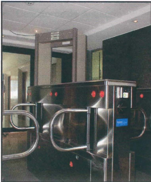
Sistema de Control de Acceso, mediante dispositivo de esclusas. Corporación DIEBOLD COLOMBIA S.A.
