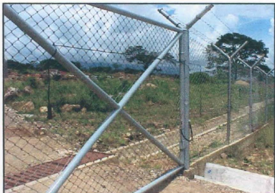
Sistema de detección de intrusión (Cable microfónico) Instalaciones Pozos de perforación complejo petrolero Casanare. BP EXPLORATION..
