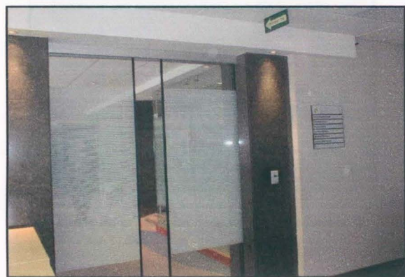
Sistema de control de acceso de aproximación por sensores. Oficinas BP EXPLORATION.
