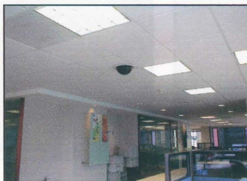
Domo de tecnología láser. Componente del sistema de CCTV. Oficinas BP EXPLORATION.
