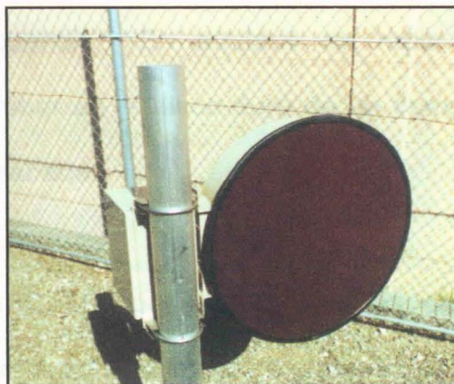
Sistema de detección de intrusión por microondas. Referencia MODEL 14101 ofrecido por Magal Group.
