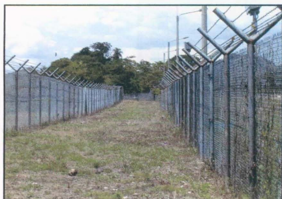
Doble malla de encerramiento de instalaciones. Complejo petrolero Cupiagua Casanare. BP EXPLORATION.
