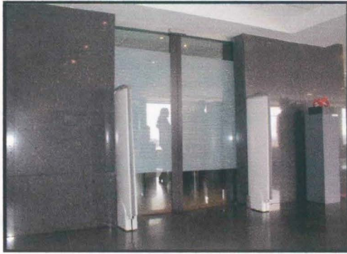
Sistema de detección electrónica oficinas BP EXPLORATION.
