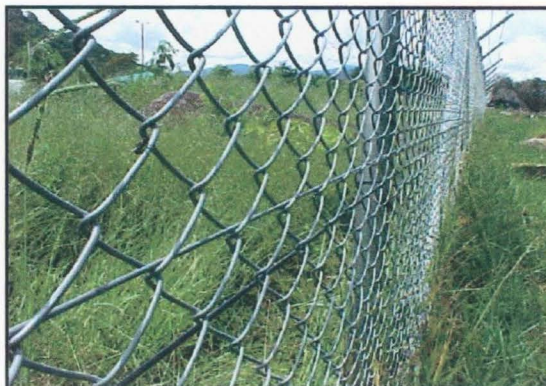
Sistema de detección de intrusión (Cable microfónico) Instalaciones Pozos de perforación complejo petrolero Casanare. BP EXPLORATION..
