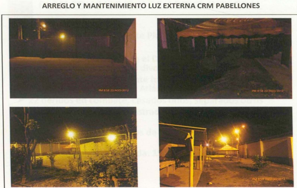
Figura 2.8. Proyecto Oficiales Profesionales de la Reserva Segunda Brigada, comité educativo y de apoyo integral, arreglo y mantenimiento alumbrado externo.
