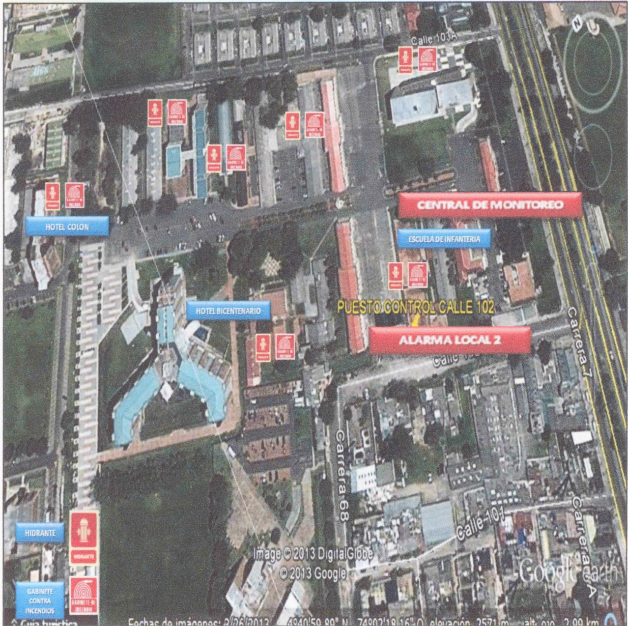
Foto 2. Ubicación de hidrantes y gabinetes contra incendios sector EAS, Escuela de Infantería, Aulas Escuela de infantería, hotel Bicentenario.
