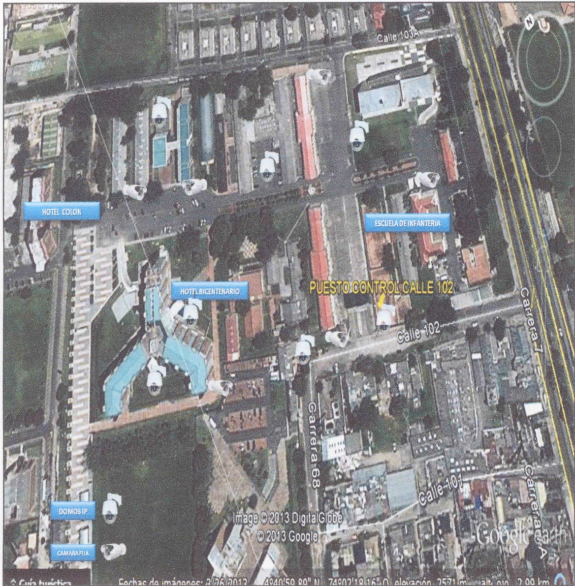
Foto 5. Ubicación circuito cerrado de televisión sector EAS, Escuela de Infantería, Aulas Escuela de infantería, hotel Bicentenario.
