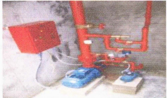
Figura 22. Activación Sistema de rociador, bombas del sistema y tubería que lo alimenta
