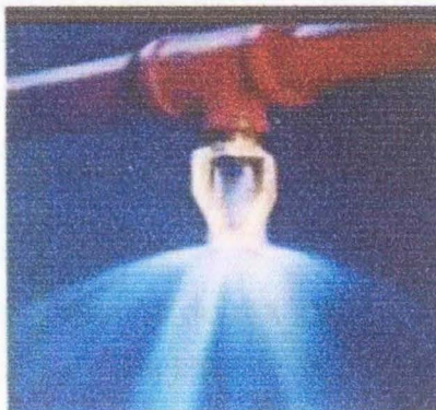
Figura 22. Activación Sistema de rociador, bombas del sistema y tubería que lo alimenta
