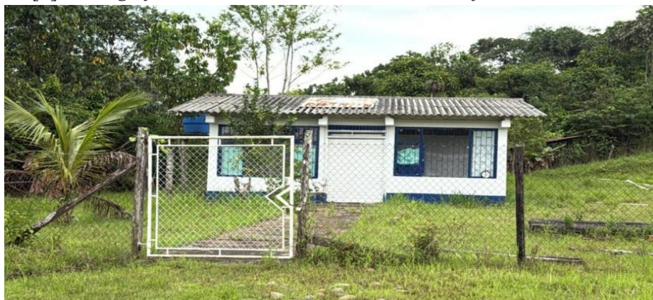
Figura 4. [5]. Fotografía del Centro médico en la actualidad fuera de servicio.
